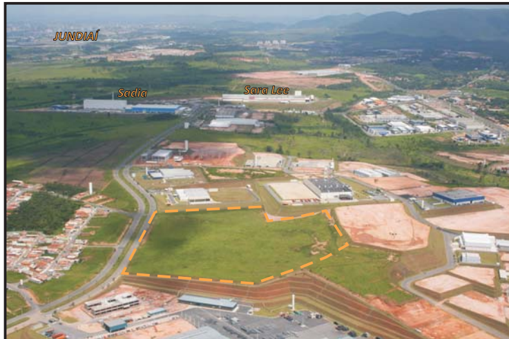
Foto aérea do local / Site overview
